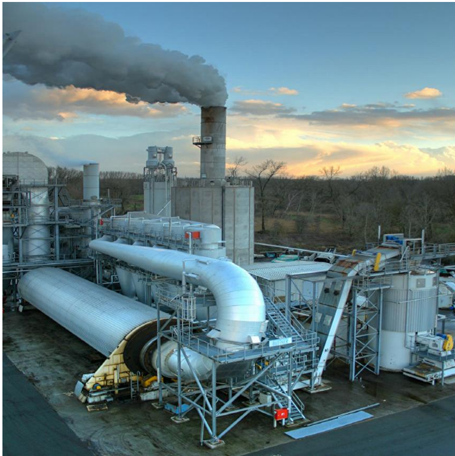
Abb.15: Trockner und Nasselektrofilter
